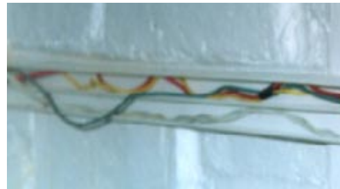
Figura 4. Fijación de canaleta.
